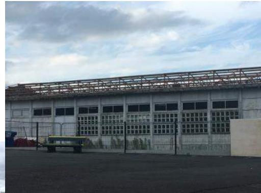
Le foyer paroissial, devenu insalubre, a été démolit
